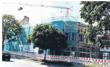
Eingerüstet: Die ersten Rundungen am Stadtteilzentrum sind bereits zu erkennen.
